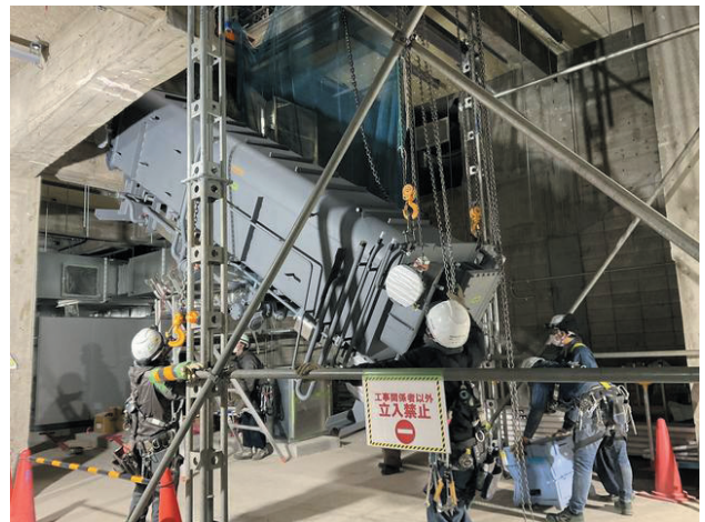
写真9 B2階 搬入用架台と搬入作業
