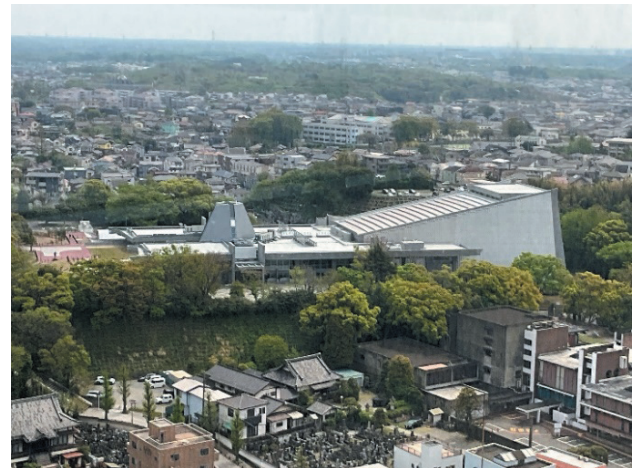
写真1 千葉県文化会館全景
