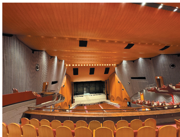
写真4 大ホール（壁面制気口）
