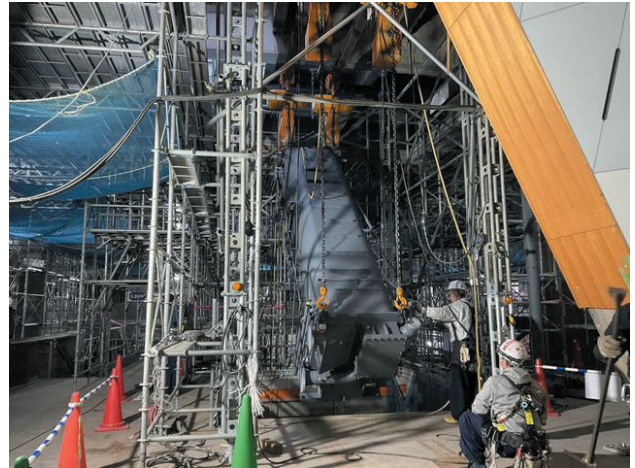
写真8 1階 搬入用架台と搬入作業
